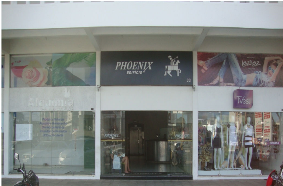
Foto 9: Edifício Phoenix, localizado na avenida Ruy Carneiro, João Pessoa, PB.
